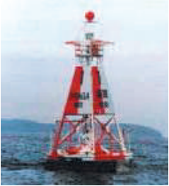
浦賀水道航路中央第一号灯浮標（東京湾口）安全水域標識です。
