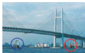
横浜外防波堤南灯台(○)と北灯台(○)
