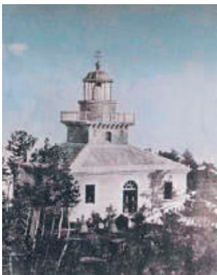
初代の観音崎灯台（神奈川県）。レンガでできていて地震で崩れたので建て替えられ、現在は3代目です。
