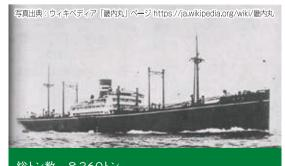
総トン数―8,360トン 全長―約135M 幅―約18M 機関―ズルツアー式ディーゼル2其(2軸式) 最大出力―8,262BPH(18.4ノット) 浸水年―1930年4月 最後―1943年5月
